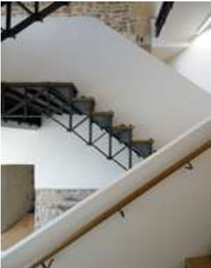
Das Wechselspiel von Altem und Neuem galt es beim Umbau der Hölder Burg zu berücksichtigen. Die historische Treppe musste brandschutztechnisch ertüchtigt werden.
