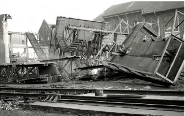
Abbruch des Fördergerüsts über Schacht Zollern II im September 1969.
