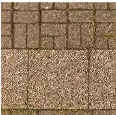
Waschbeton wurde überwiegend in den 1960er und 1970er Jahren eingesetzt, wie zum Beispiel in der Kielstraße in der Dortmunder Nordstadt.
