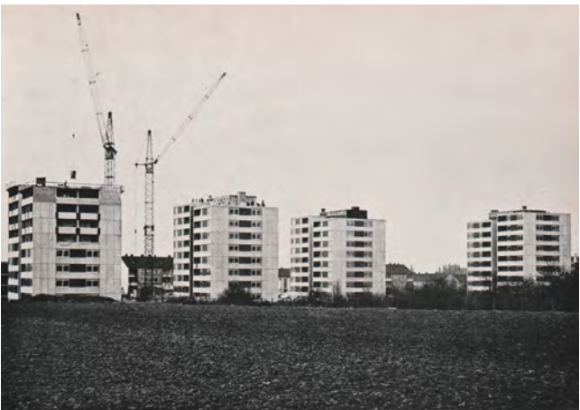
Bau einer Siedlung aus Punkthochhäusern an der Stippskuhle in Dortmund Körne, 1968.
