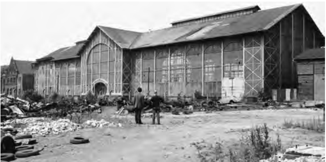
Die Maschinenhalle zeigt 1970 deutliche Spuren von Vernachlässigung und Verfall.
